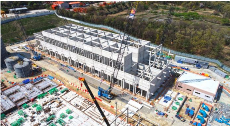
KC산업이 진행한 여주 천연가스 발전소 내 쿨링타워 PC 공사 현장 /KC산업
