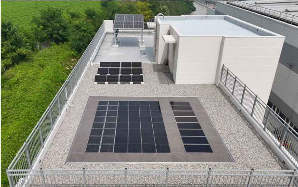
GS건설이 개발한 All in One 옥상 바닥시스템. 태양광모듈(아래)과 철골 구조물에 설치된 기존의 일반 태양광패널(위).
