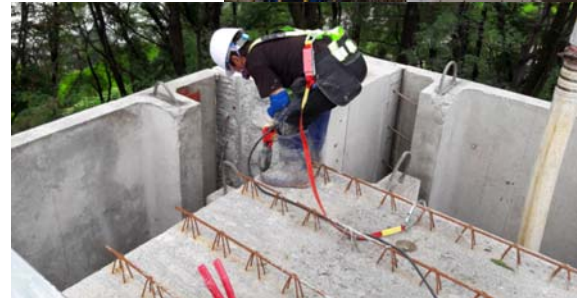
<그림 10> DCW 목업 코너부위 접합부 상세 및 코너 조립
