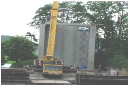
<그림 20> DCW 목업 조립 순서
