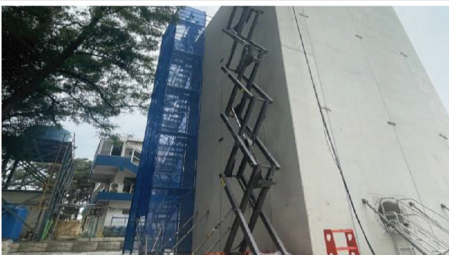
(g) Mock-up 구조물 워킹타워 설치
