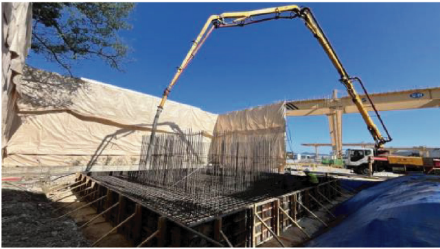
(a) Mock-up 현장 기초철근 배근
