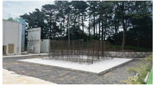
(b) 기초콘크리트 타설
