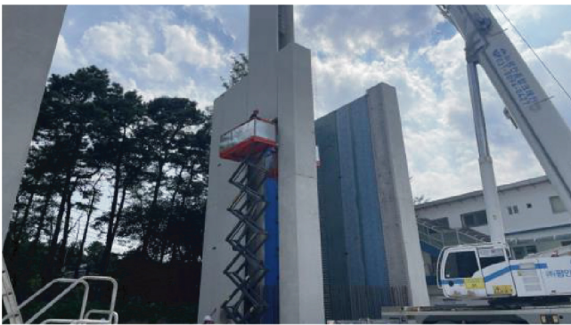
(e) Mock-up 구조물 PC 더블월 설치
