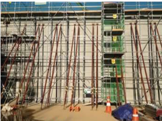
[ 상하 지지대 설치 ]
