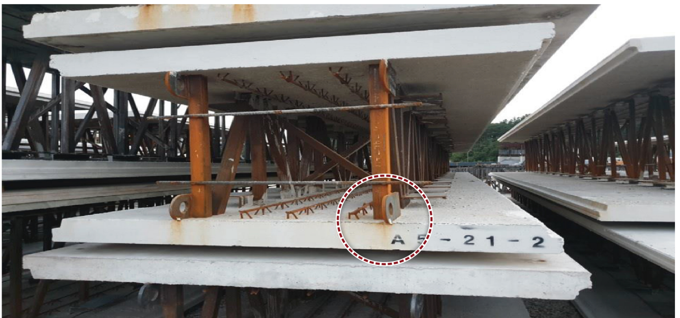
[ 운반 중 차량 회전등으로 인한 폭방향 변형 방지용 브레이싱 ]
