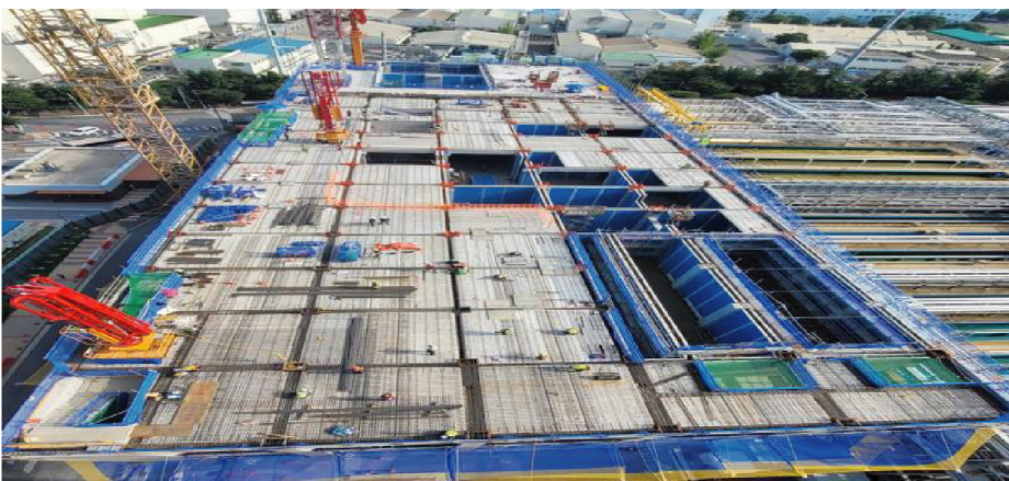
⑤ PC기둥, 거더, 슬라브 조립 및 벽체, 슬라브 동시타설 (조립 완료 후 동시타설)
