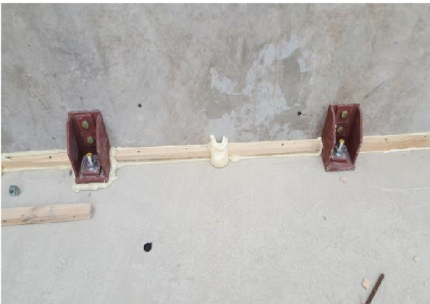
③ PTW 설치 (하부양카 고정)
