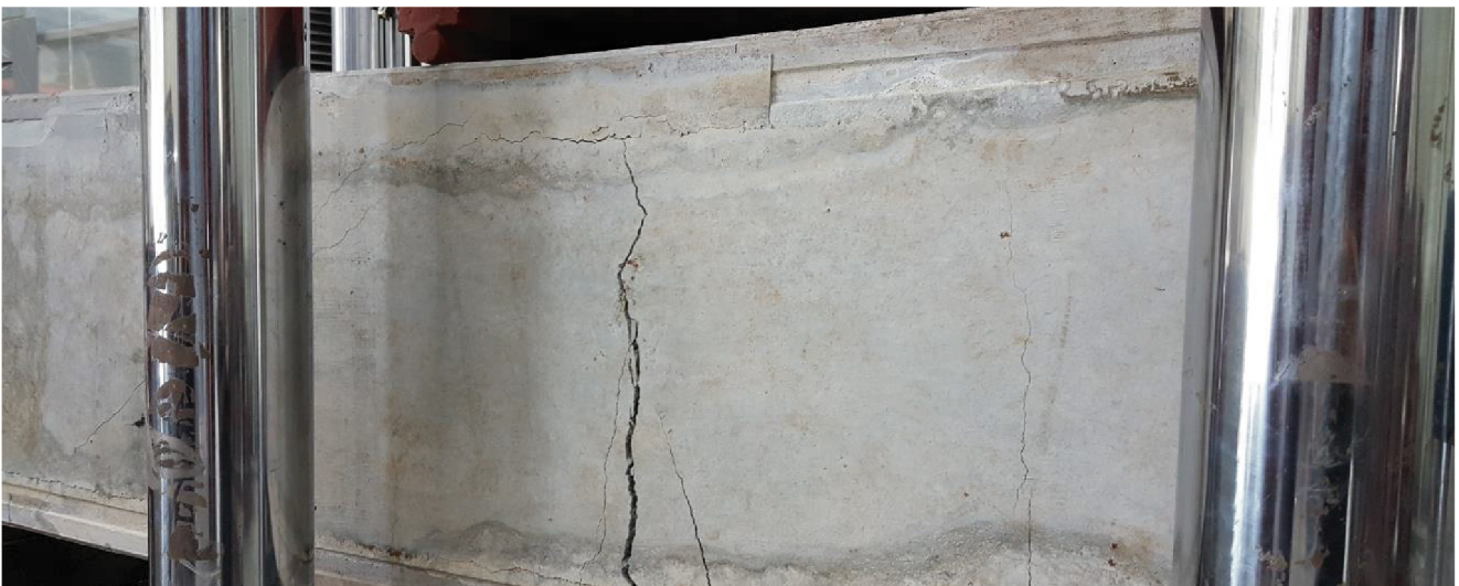
[ 실험체의 균열 양상 ]
