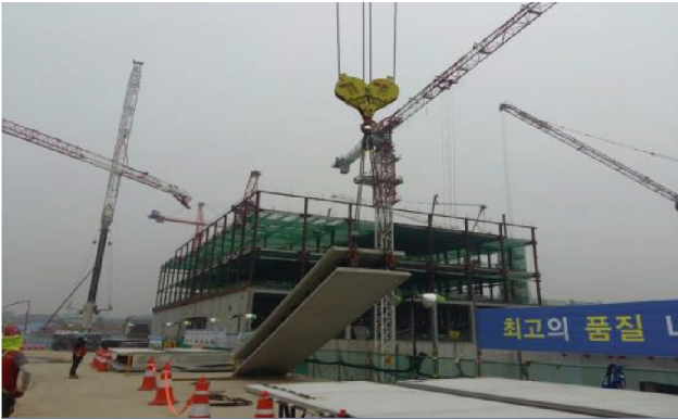
① PTW현장 반입 및 기립 (고무패드or타이어 적용 하단부 균열방지)
