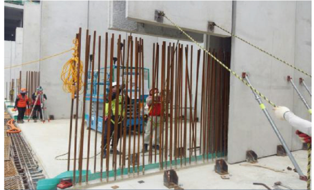
② PTW 설치 (거치대, 추가인양장비, 써포트 불필요)
