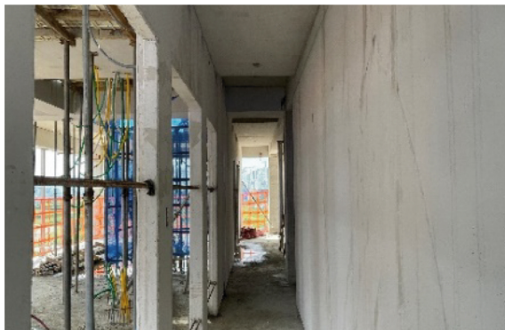
(e) 주동 내부 조립
