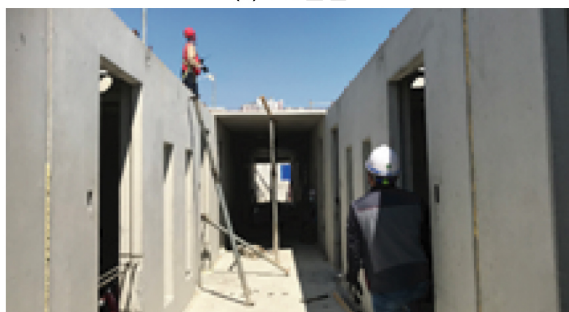
(c) PC 조립(복도슬래브)
