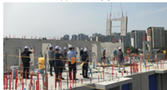
(d) PC 조립(외벽)
