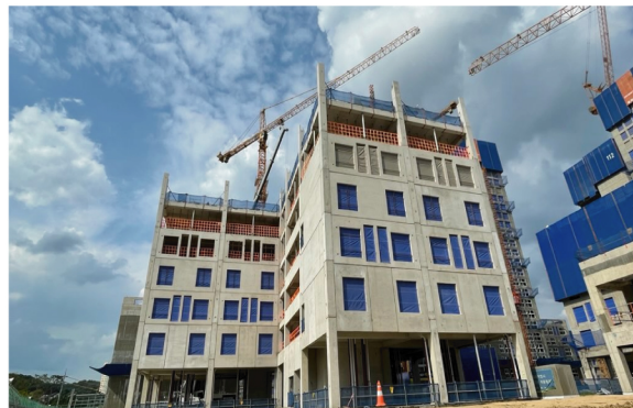
(f) 조립 중 외부 전경
