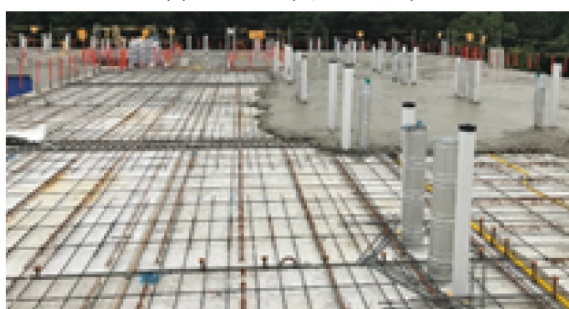
(e) 슬래브 상부근 배근, 덧침 콘크리트타설
