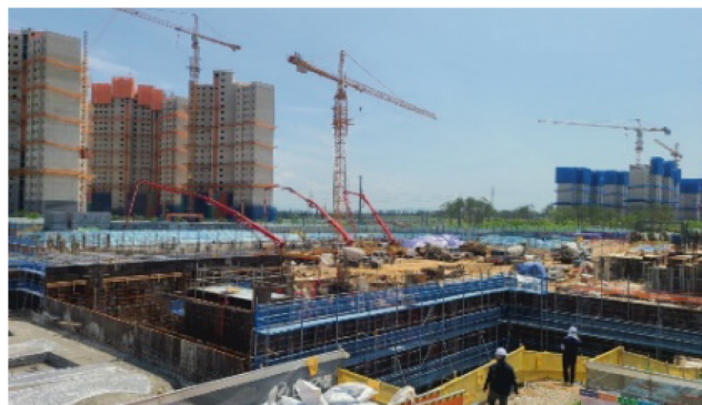
(b) 지하층 공사
