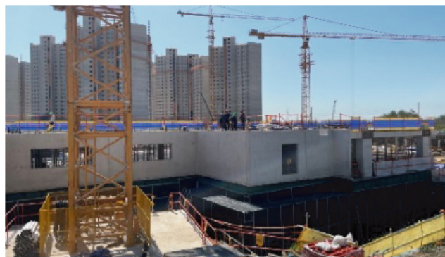
(d) 1개층 벽체 슬래브 조립
