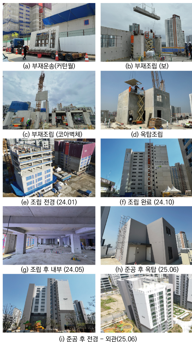
[그림 17] PC아파트 조립 과정 및 준공 후 전경
