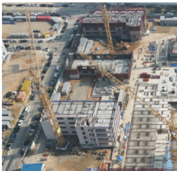
[그림 17] PC아파트 PC부재 양중 및 조립용 크레인 설치, 운용 현황
