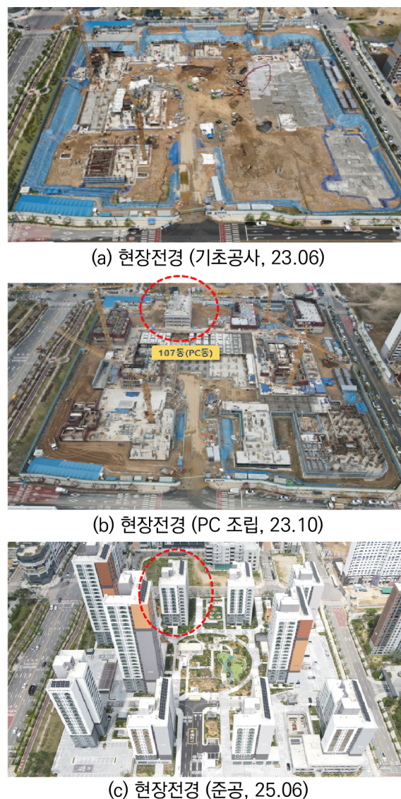
[그림 18] PC아파트 현장 전체 전경
